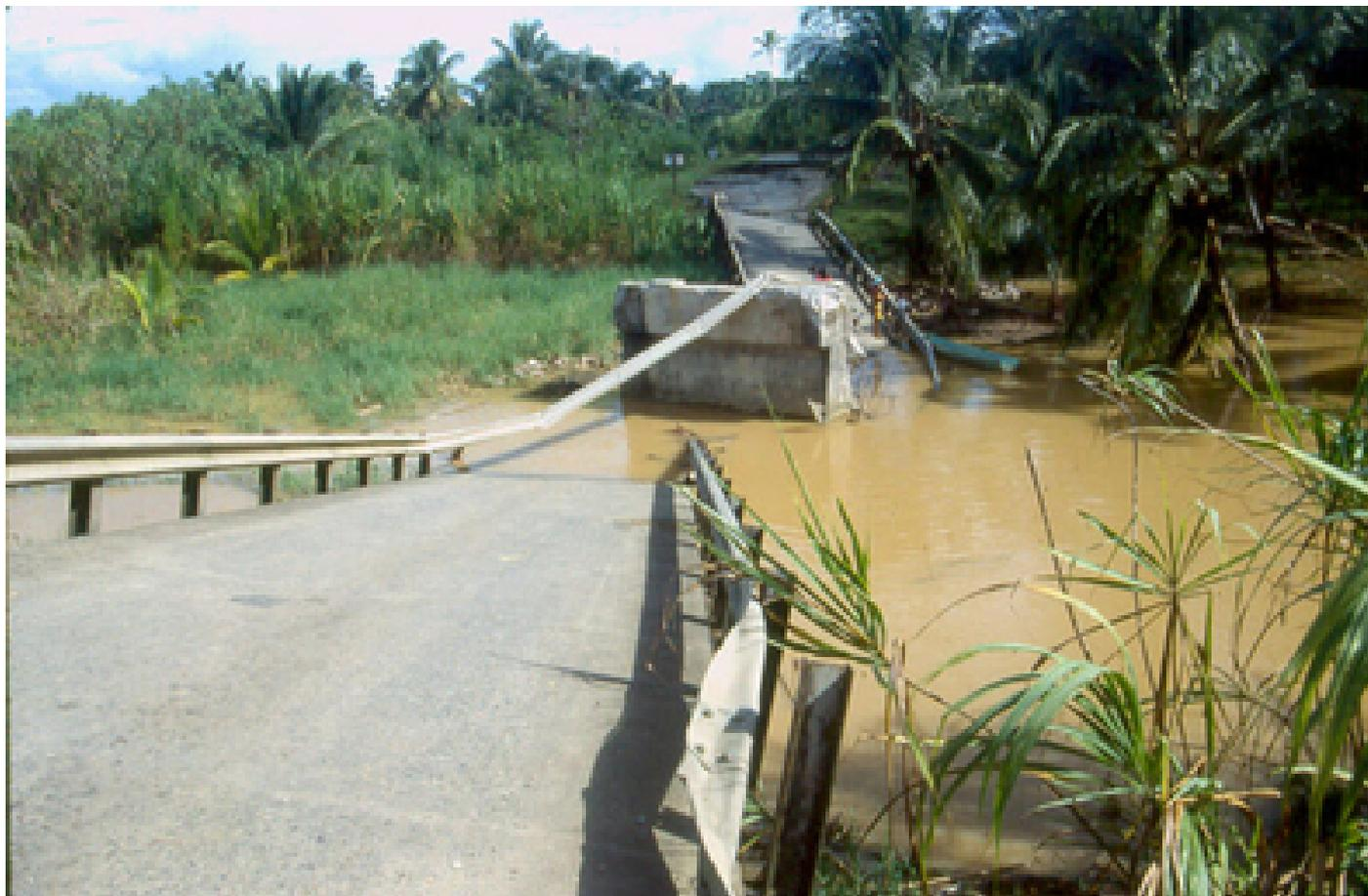
El sismo provocó el colapso de muchas estructuras viales, como la caída de este puente en Bananito, Limón. Foto: cortesía del Dr. Sergio Mora Castro.
