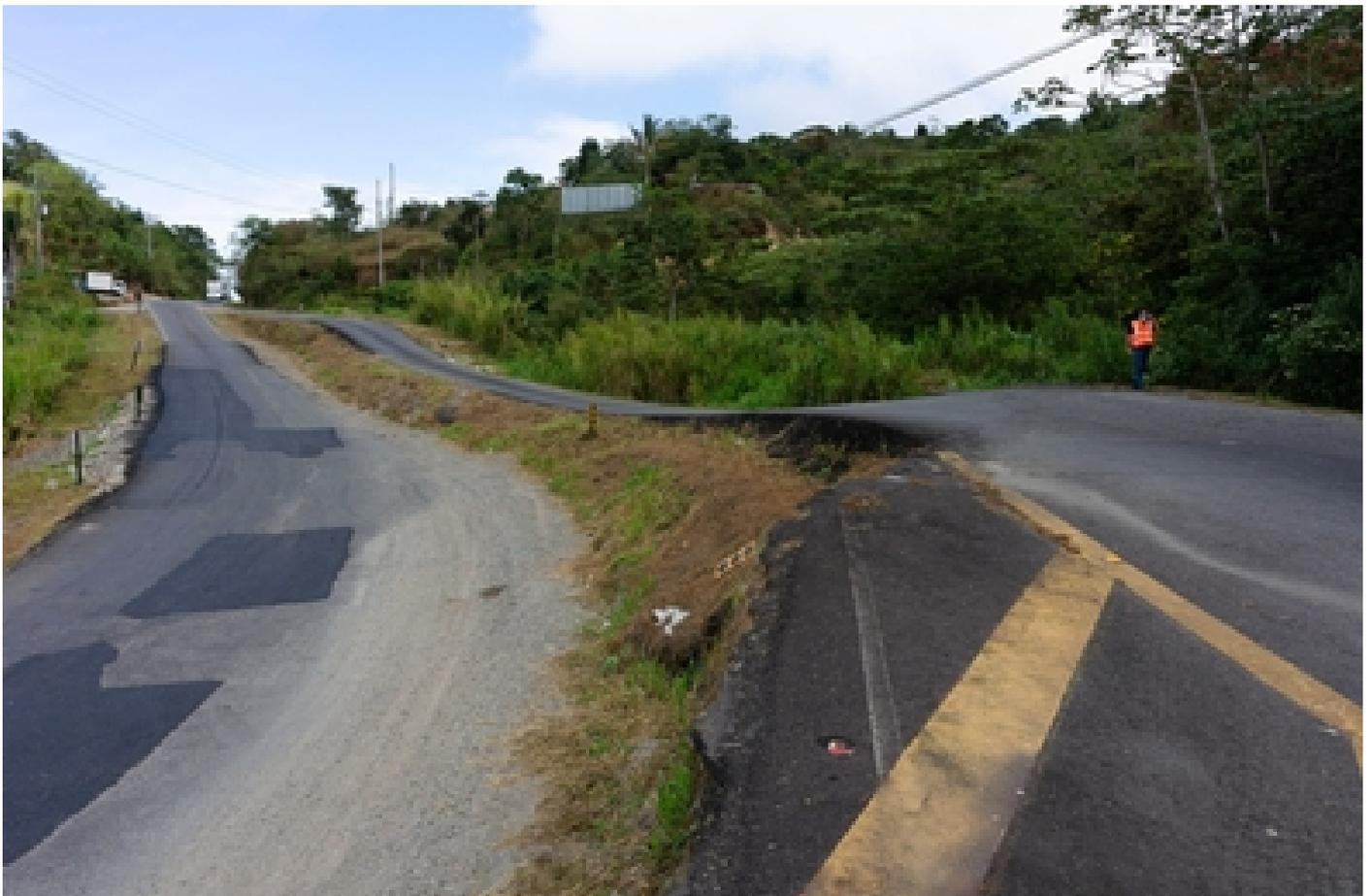
El equipo de profesionales del LanammeUCR identificó zonas de la Ruta 1 que presentan problemas de estabilidad de taludes y deslizamientos que atraviesan la carretera. Foto cortesía LanammeUCR.
