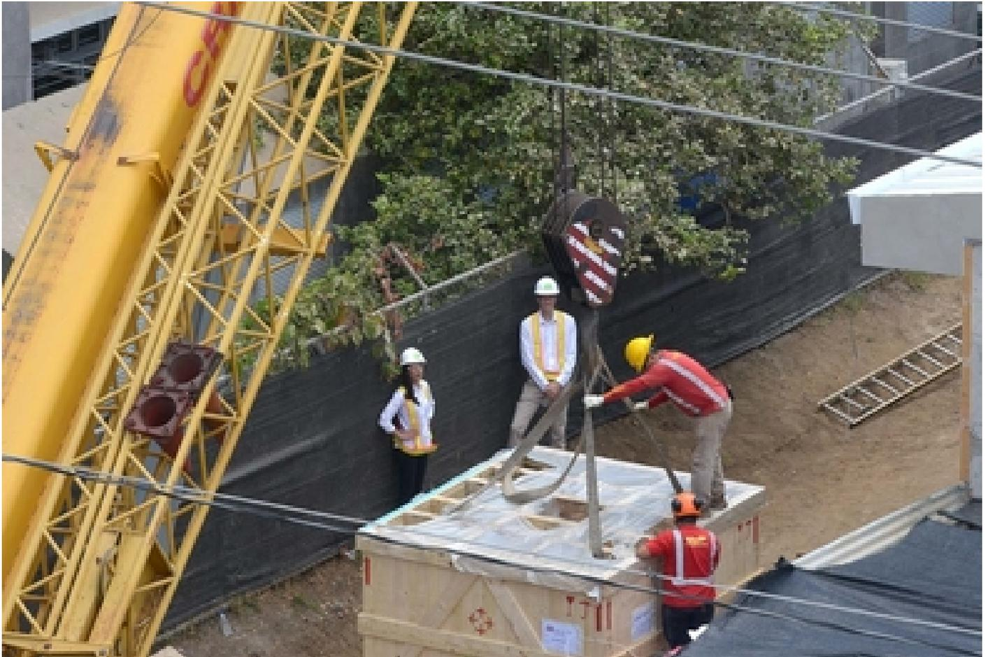
El ciclotrón o acelerador de partículas subatómicas para la generación de radioisótopos quedó colocado en una bóveda bajo tierra con paredes de concreto de dos metros de espesor. Karla Richmond
