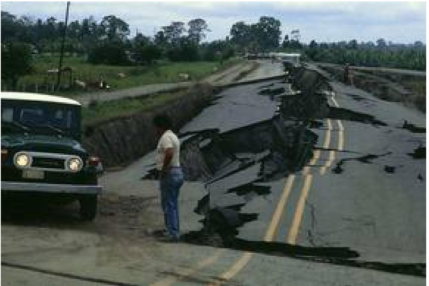
La licuefacción de los suelos, típica de zonas con depósitos arenosos, provocó el agrietamiento de las carreteras y, por ende, la interrupción del paso (foto Sergio Mora Castro).
