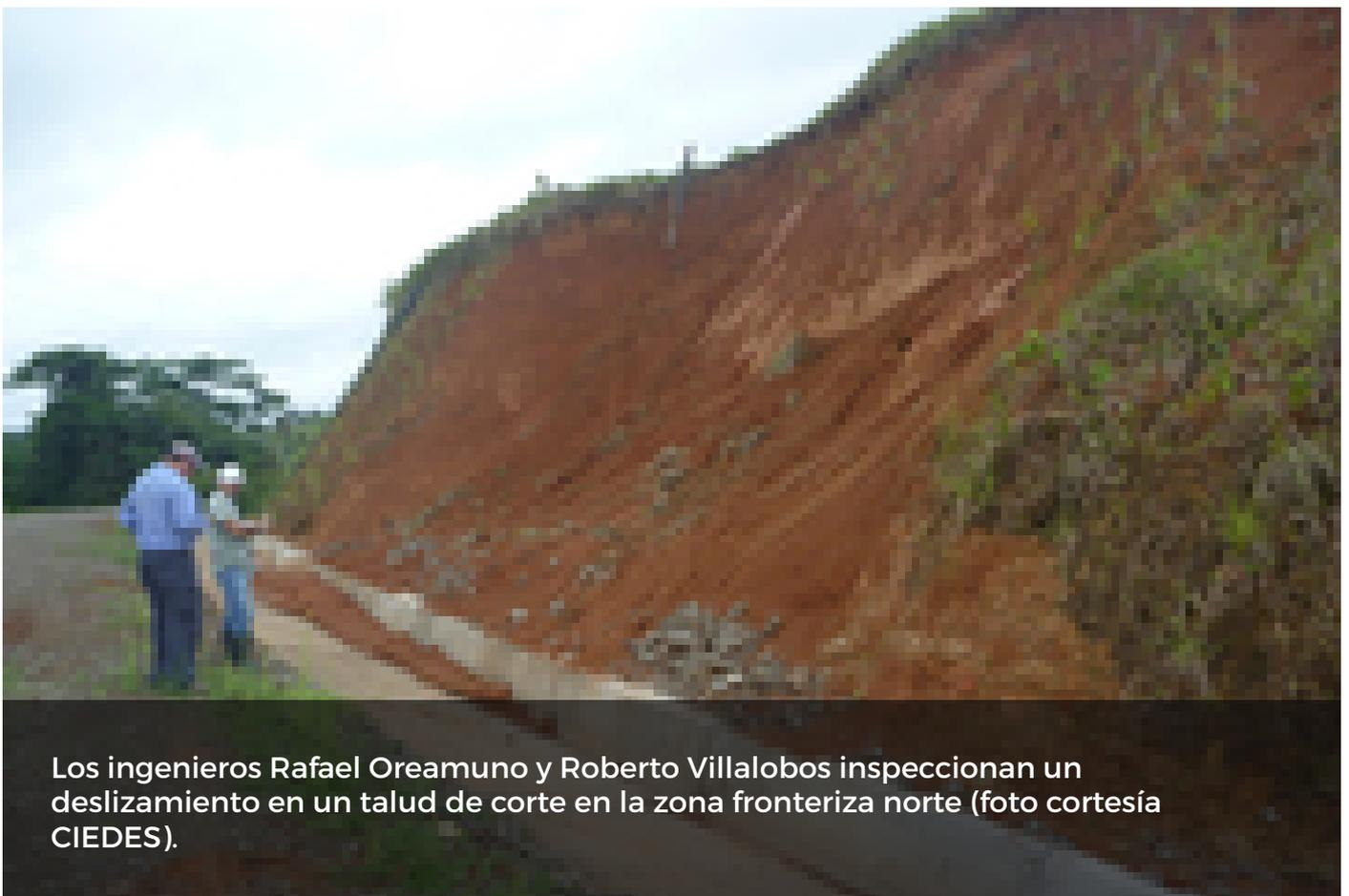
Los ingenieros Rafael Oreamuno y Roberto Villalobos inspeccionan un deslizamiento en un talud de corte en la zona fronteriza norte (foto cortesía CIEDES).
