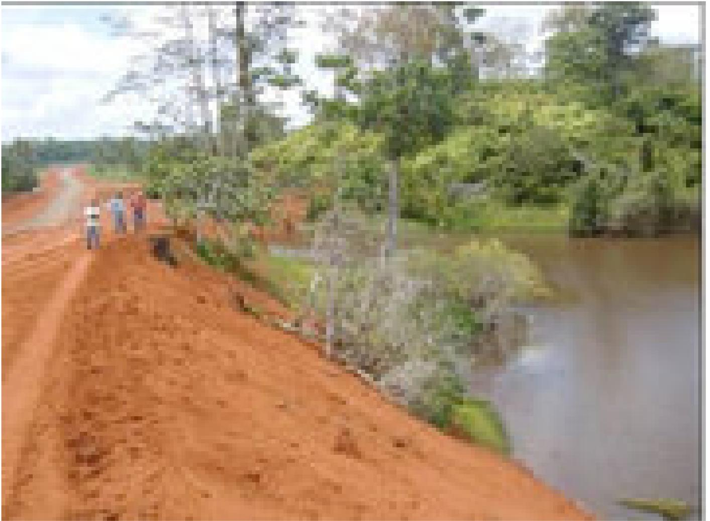
La imagen tomada del Informe del Lanamme captada en mayo del presente año muestra el inadecuado manejo del material de corte y talud (foto Lanamme).
