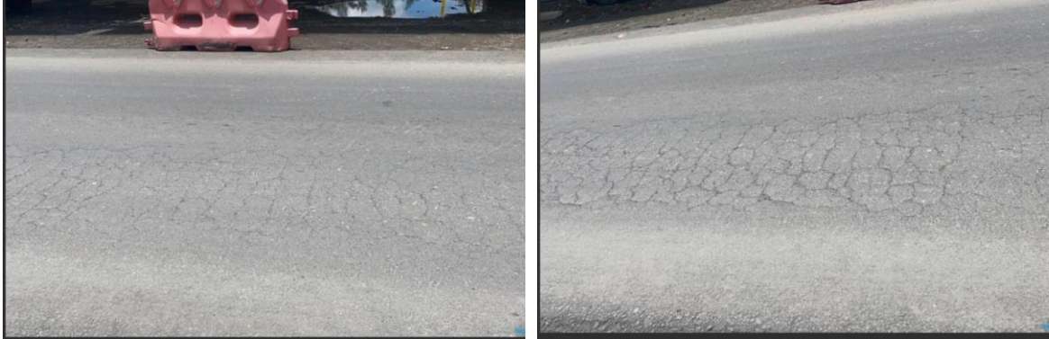
Figura 15. Agrietamiento en capa de mezcla asfáltica, cerca del estacionamiento 1+350 del eje 17. Fecha 25/08/2023.
