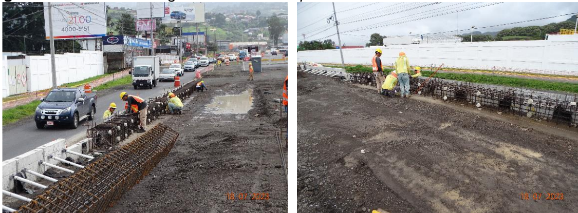
Figura 18. Armadura de viga de amarra muro paso elevado Avenida 23
