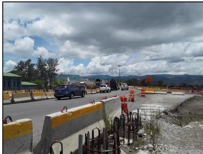
Figura 25. Combinación de dispositivos de control de tránsito no uniforme (elementos plásticos y de concreto), frente a plaza de deportes, La Lima, Cartago.
