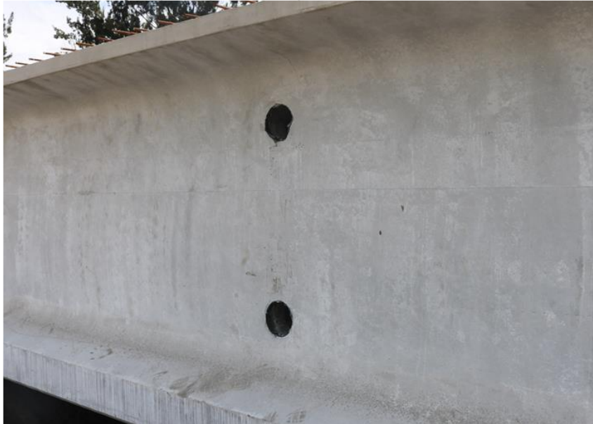
Figura 16. Acabado en vigas principales del paso de Avenida 23. Fecha: 19/7/2022.
