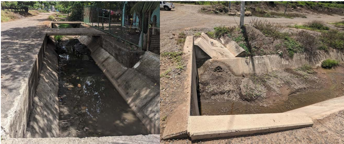
Figura 31. Canal de drenaje trapezoidal: sección limpia, pero con agua estancada (izq.) y sección sedimentada (der.)
