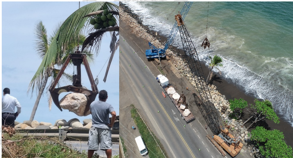
Figura 27. En estas imágenes se puede ver la descarga de los bloques de caliza de tamaño métrico y los bloques más pequeños colocados en la escollera
