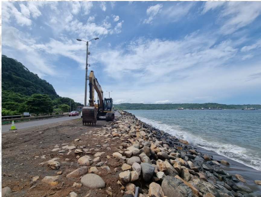
Figura 30. Reconstrucción de escollera en la RN-23 en el sector de Caldera
