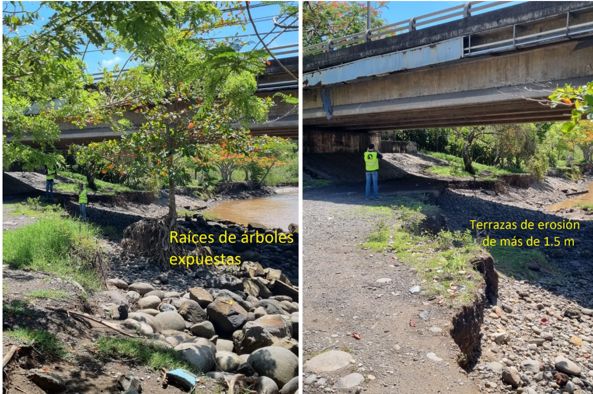
Figura 33. Evidencias de erosión en el sector de la desembocadura del río Barranca
