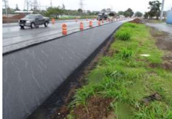
Figura 18. Tramo estabilizado y con capa asfáltica. 300m Oeste del cruce con Ruta 117. Fechas: 19 enero de 2021. Ampliación externa sur de la vía. Fuente: LanammeUCR.
