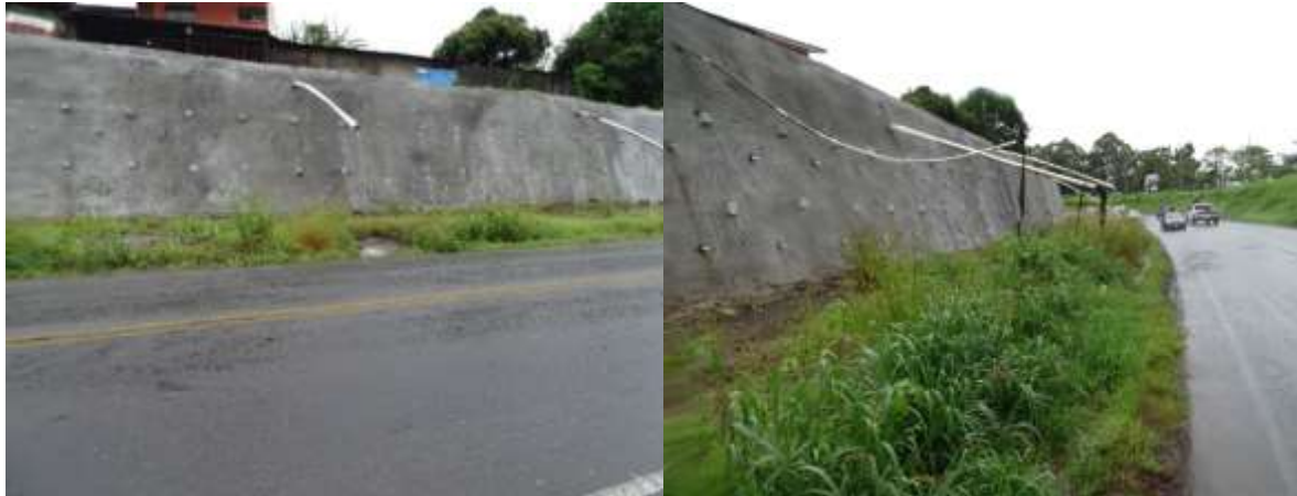
Figura 29. Tuberías colocadas para la descarga de aguas residuales/jabonosas. Fecha: 23 de julio de 2021. Fuente: LanammeUCR
