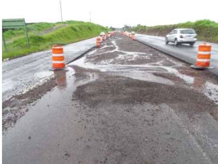
Figura 8. La base está expuesta y se está erosionando producto del agua de lluvia, estacionamiento 1+150, sin embargo, esta condición es generalizada hasta el estacionamiento 2+280. Fecha: 23 de julio de 2021. Fuente LanammeUCR.
