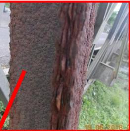
Corrosión con pérdida de sección en elementos de soporte lateral
