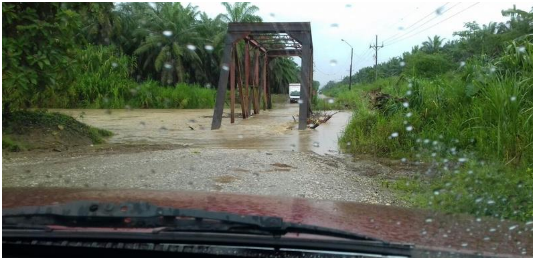
Puente sobre el río Coto, Tormenta Nate, 2017 (CRHoy)
