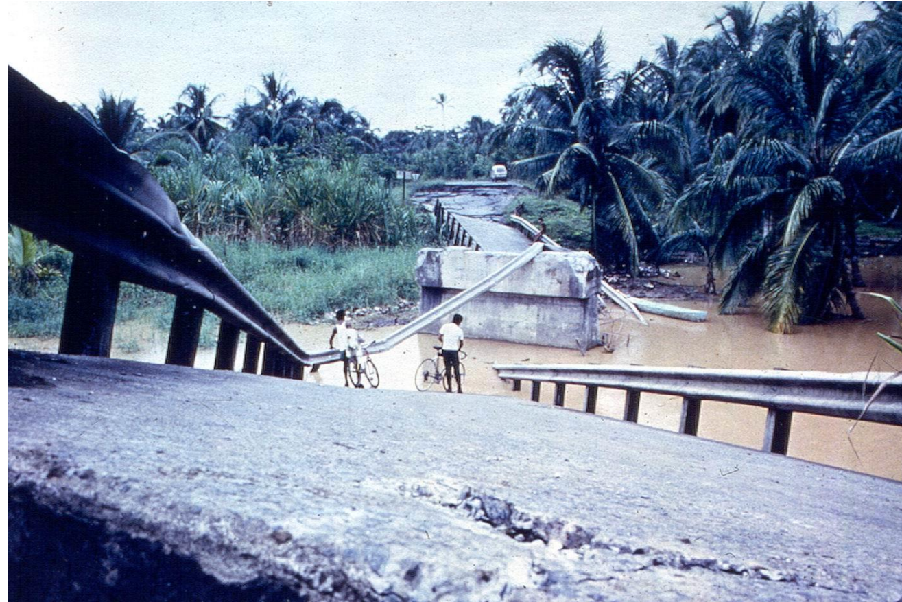
Puente sobre el río Bananito, Terremoto de Telire-Limón, 1991 (Laboratorio de Ingeniería Sísmica)
