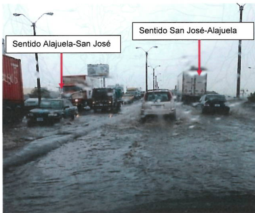
Figura 4. Vehículos transitando por el acceso sureste inundado con alta probabilidad de experimentar hidroplaneo. (Fuente: www.teletica.com )
