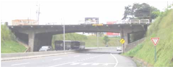
Figura 8. Superestructura tipo marco rígido.
