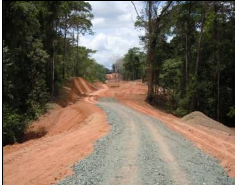
Figura 41. Inicio de zona con material granular, tramo 8 Fuente: LanammeUCR, Mayo 2012.
