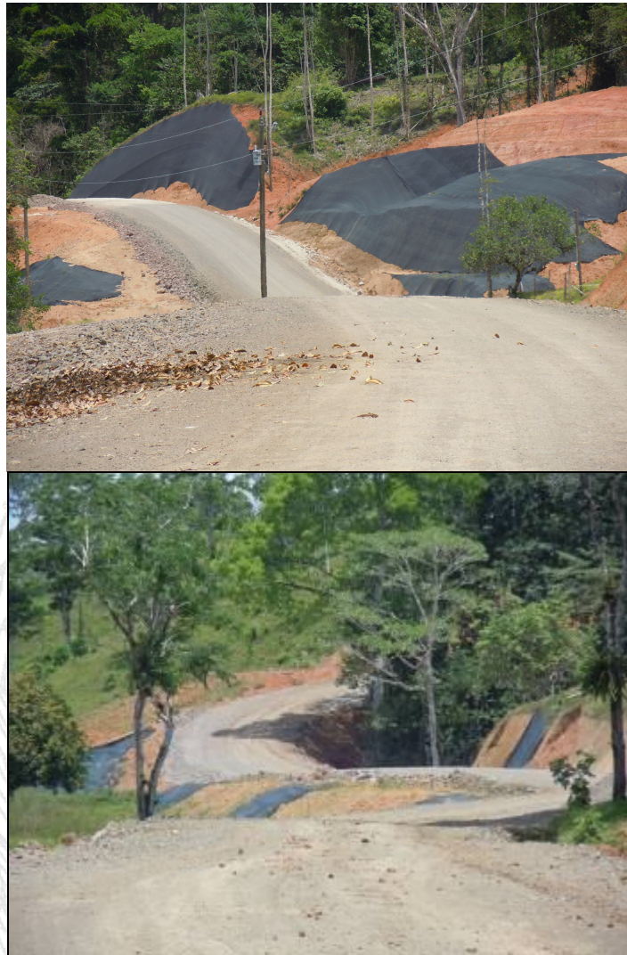
Figura 38. Sarán colocado en taludes de corte y relleno, tramo 8 Fuente: LanammeUCR, Mayo 2012.
