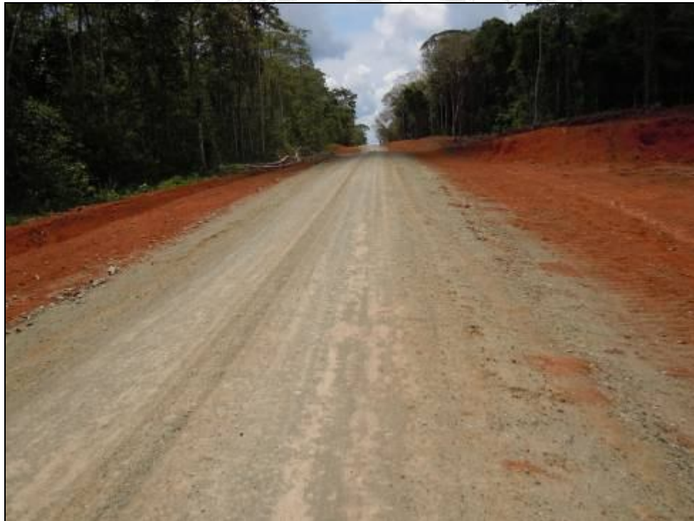
Figura 44. Colocación de material tejido sobre los taludes en forma dispersa. Fuente: LanammeUCR, Mayo 2012.
