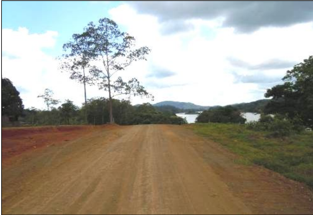
Figura 23. Nivel de rasante tramo 5. Fuente: LanammeUCR, Mayo 2012.
