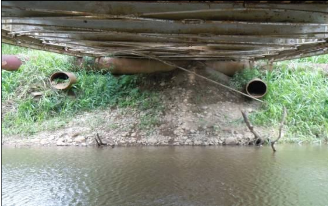
Figura 6. Apoyos puente Bailey tramo Fátima- Boca Río Sarapiquí. Fuente: LanammeUCR, Mayo 2012.
