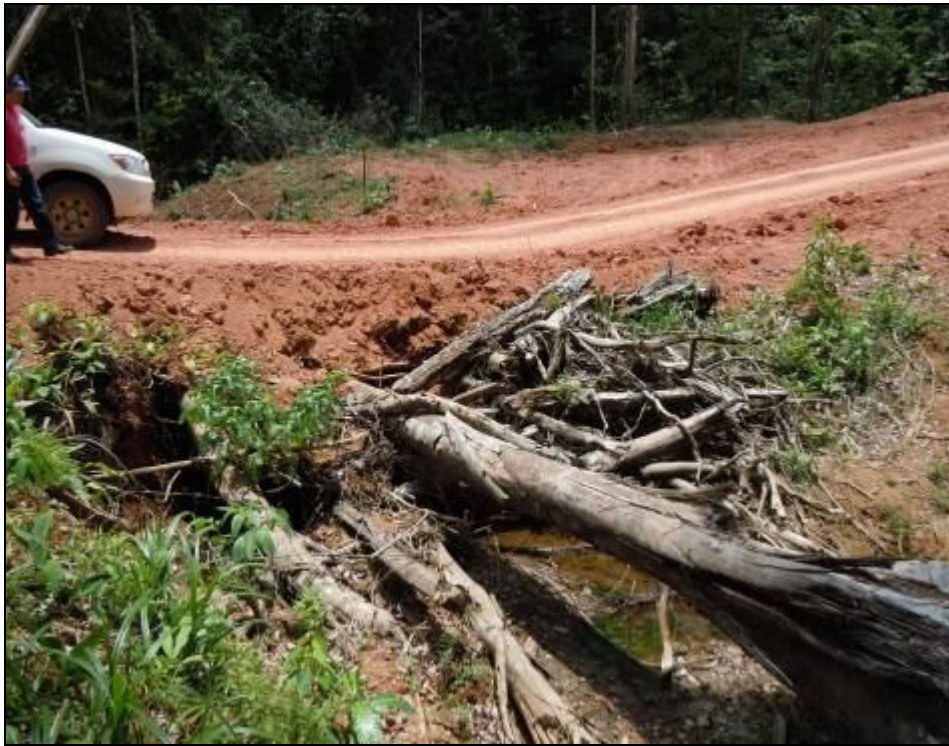
Figura 40. Paso de agua provisional de troncos, tramo 8 Fuente: LanammeUCR, Mayo 2012.
