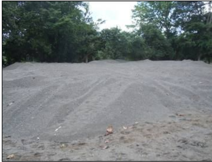
Figura 24. Nivel de rasante tramo 5. Fuente: LanammeUCR, Mayo 2012.
