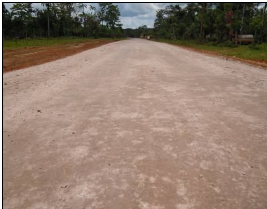
Figura 22. Material colocado sobre la Ruta en el sector de Cureña. Fuente: LanammeUCR, Mayo 2012.
