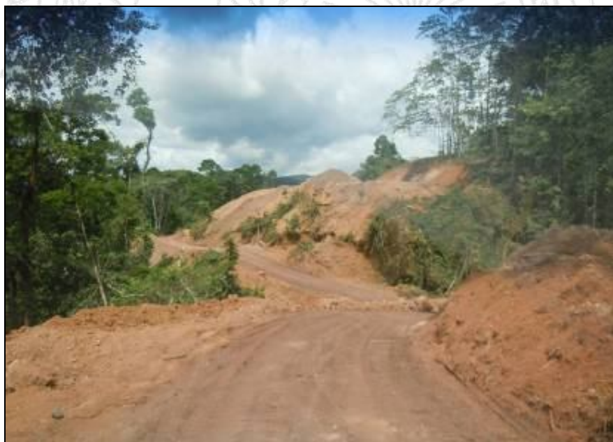
Figura 26. Zona de corte y relleno, tramo 6. Fuente: LanammeUCR, Mayo 2012.
