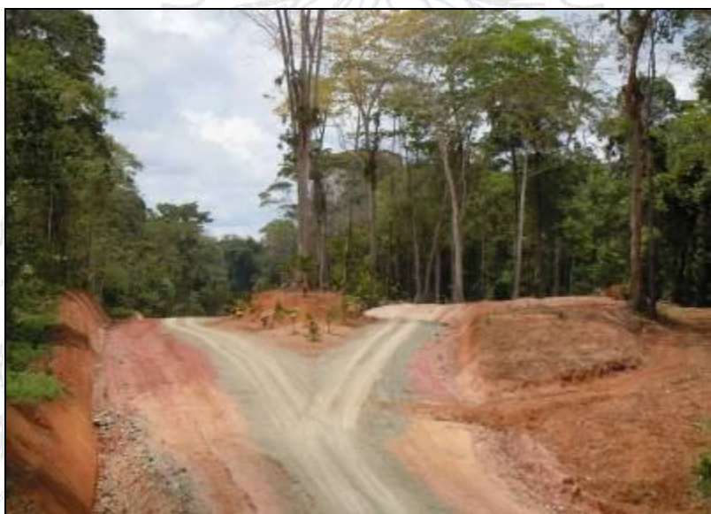
Figura 43. Sección del camino donde se rodean árboles existentes, tramo 8 Fuente: LanammeUCR, Mayo 2012.
