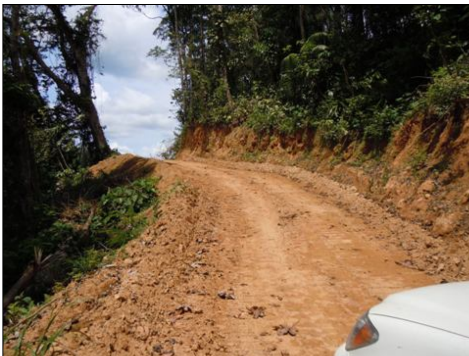
Figura 30. Camino alternativo a la trocha, tramo 6. Fuente: LanammeUCR, Mayo 2012.
