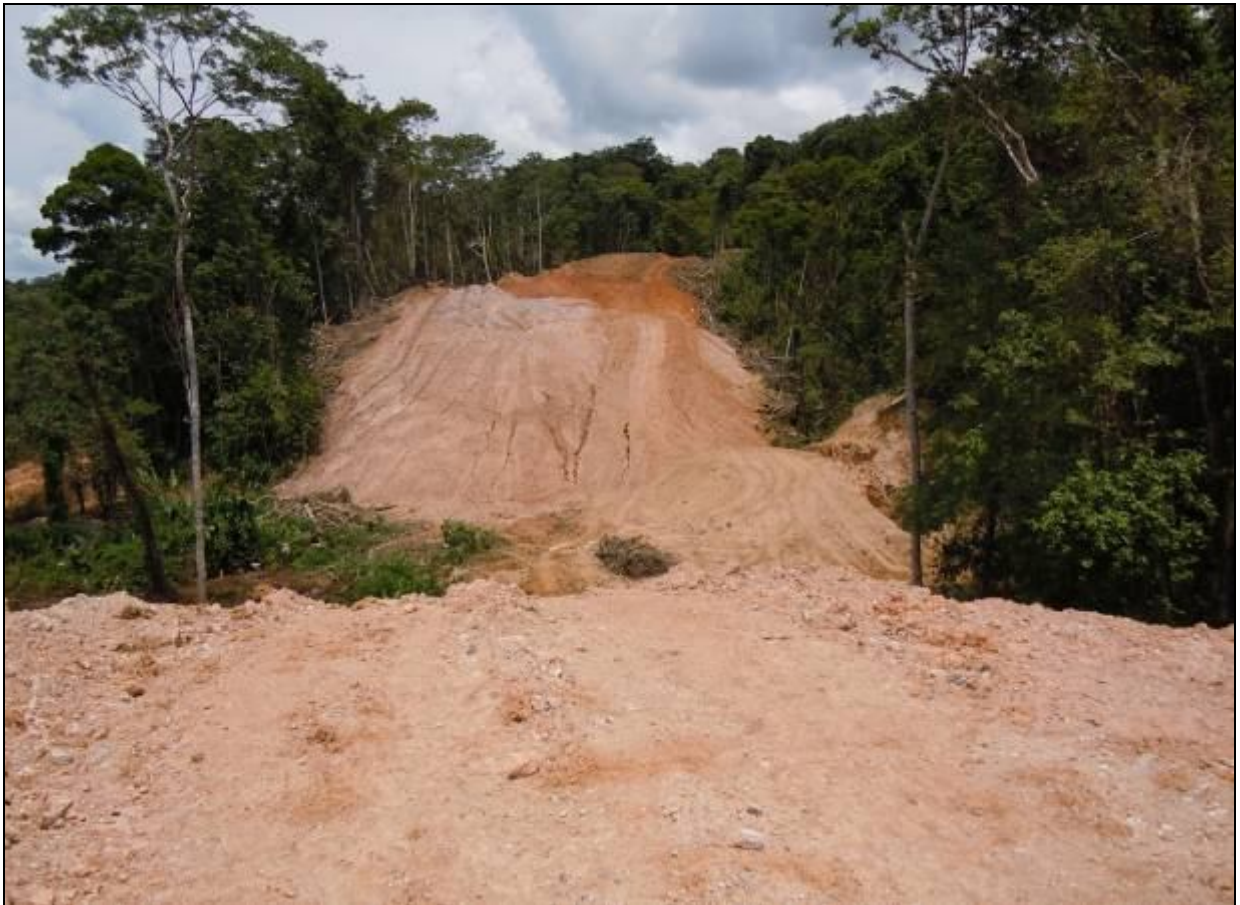
Figura 31. Zona de corte y relleno en zona montañosa, tramo 6. Fuente: LanammeUCR, Mayo 2012.
