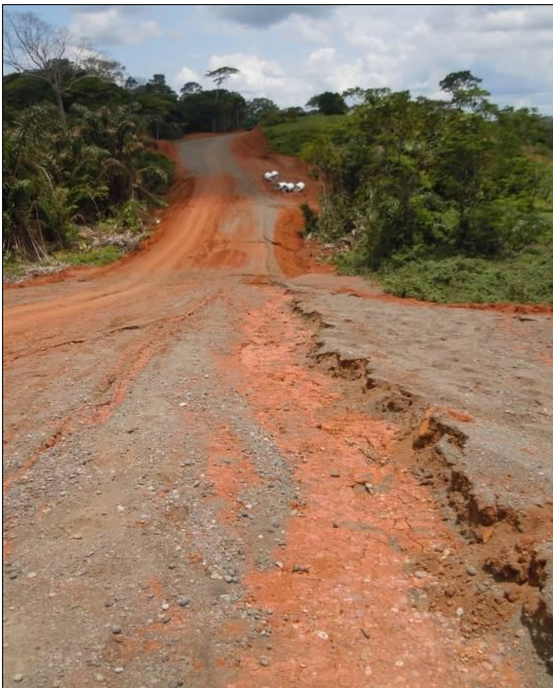
Figura 20. Arena colocada sobre la subrasante en tramo 4. Fuente: LanammeUCR, Mayo 2012.
