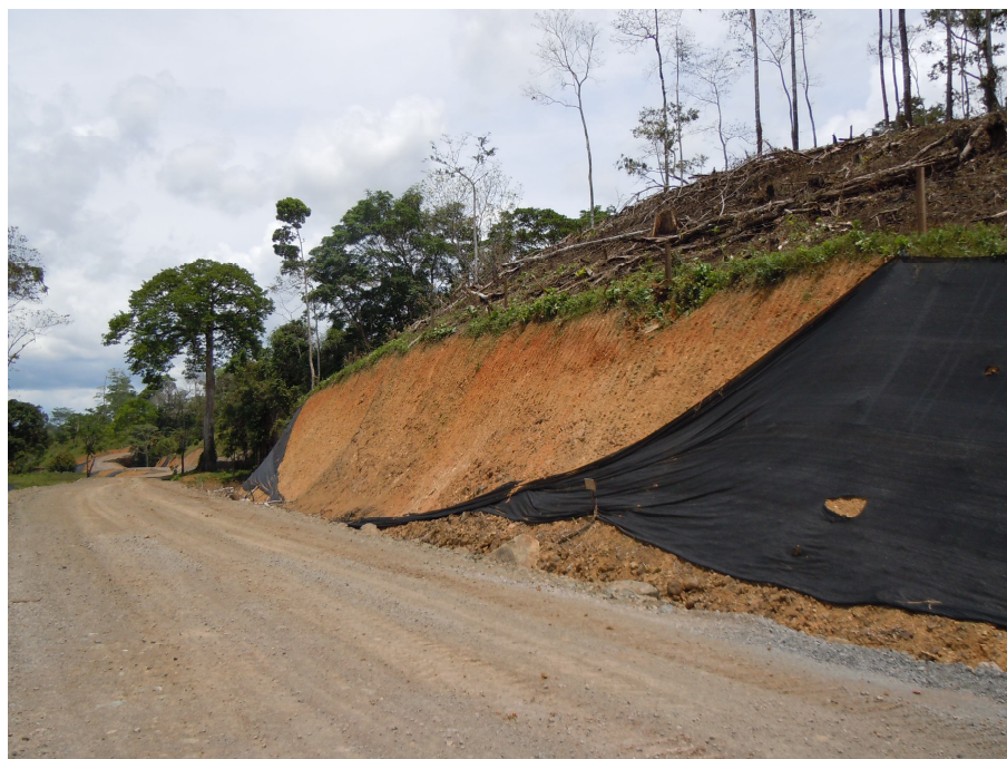
Figura 36. Colocación de material tejido sobre los taludes en forma dispersa. Fuente: LanammeUCR, Mayo 2012.
