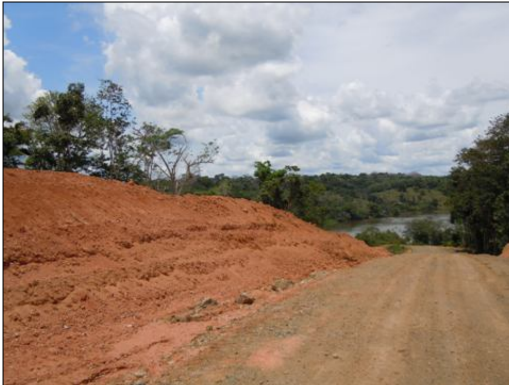
Figura 39. Depósito de material excavado, tramo 8 Fuente: LanammeUCR, Mayo 2012.
