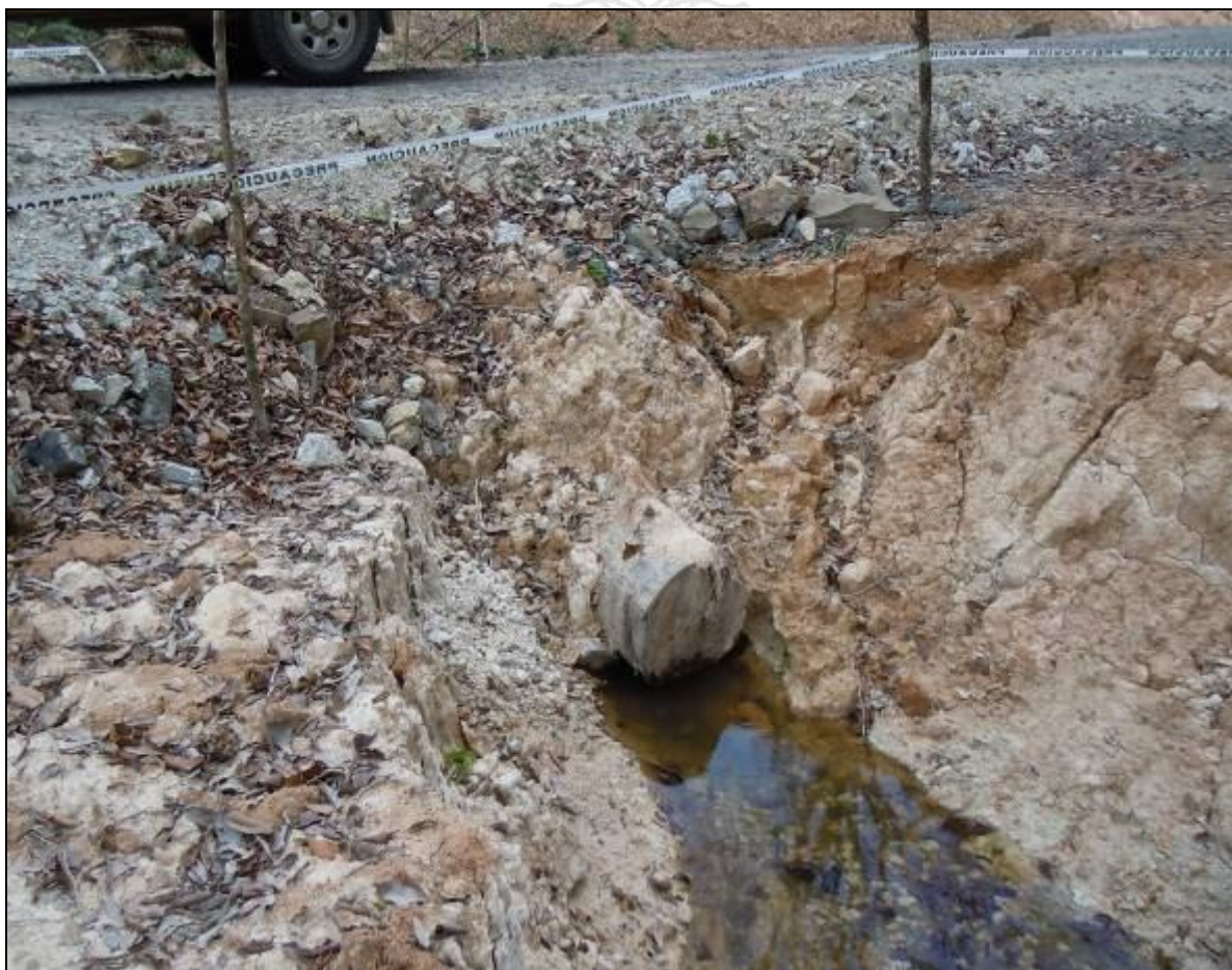
Figura 34. Paso de agua utilizando troncos en tramo 7. Fuente: LanammeUCR, Mayo 2012.
