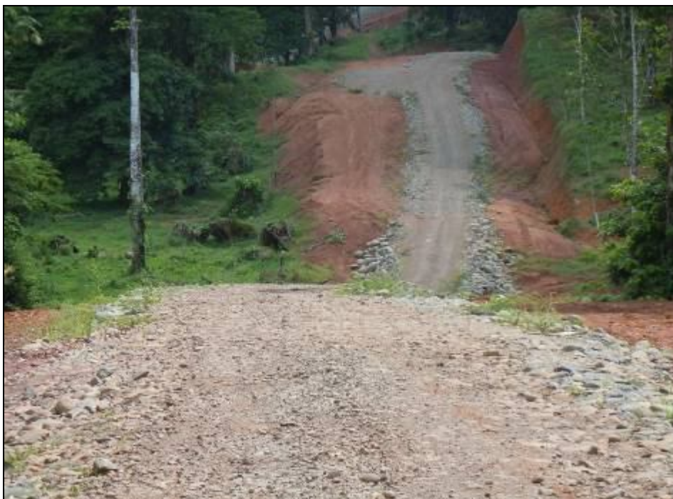
Figura 11. Zona de cortes y rellenos, tramo 2. Fuente: LanammeUCR, Mayo 2012.
