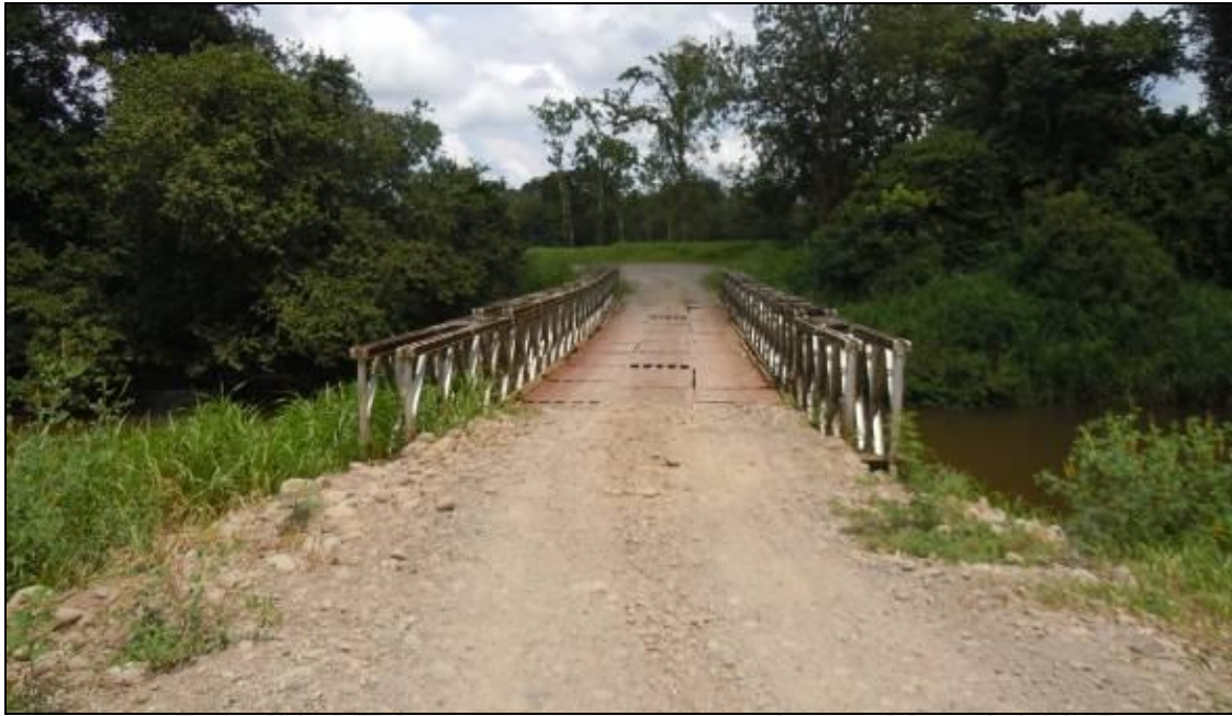
Figura 5. Puente Bailey tramo Fátima- Boca Río Sarapiquí. Fuente: LanammeUCR, Mayo 2012.
