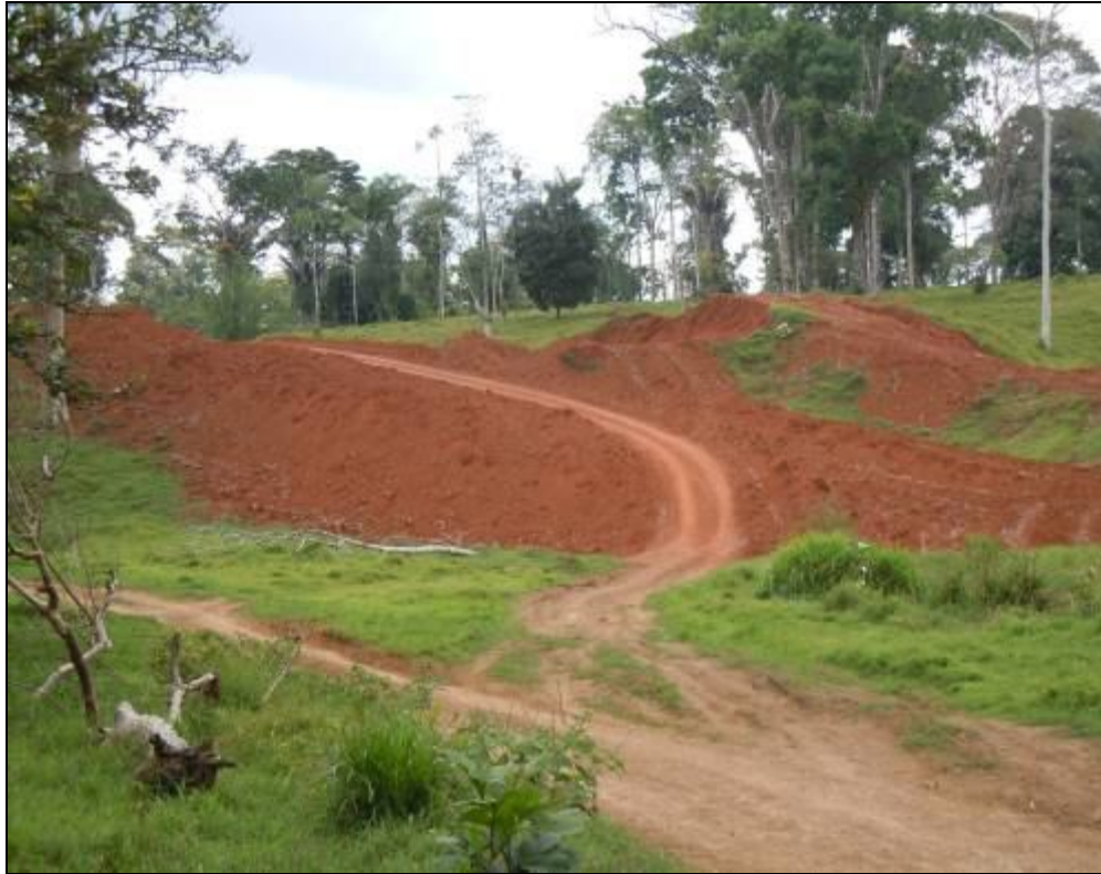
Figura 19. Rellenos presentes en tramo 4. Fuente: LanammeUCR, Mayo 2012.
