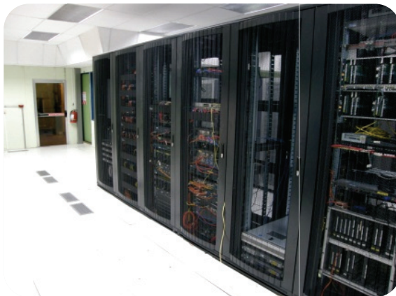
Bastidor de equipo de comunicaciones en el Centro de Datos CI.
