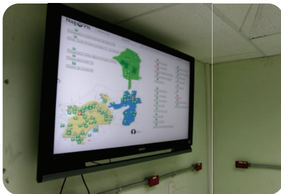
Sistema de monitoreo de la RedUCR instalado en el Centro de Datos CI.
