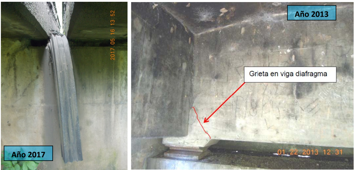
F36: Puente sobre el río Rosales. Deterioro del sello en la junta de expansión y agrietamiento en viga diafragma la cual se mantiene.
