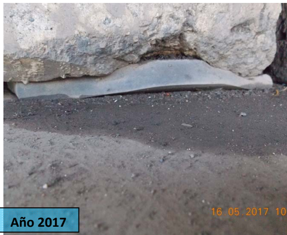
F20: Paso Superior Aeropuerto (Entrada Terminal). Apoyo cuya deformación evidencia sobrecarga o pobre desempeño de los apoyos utilizados
