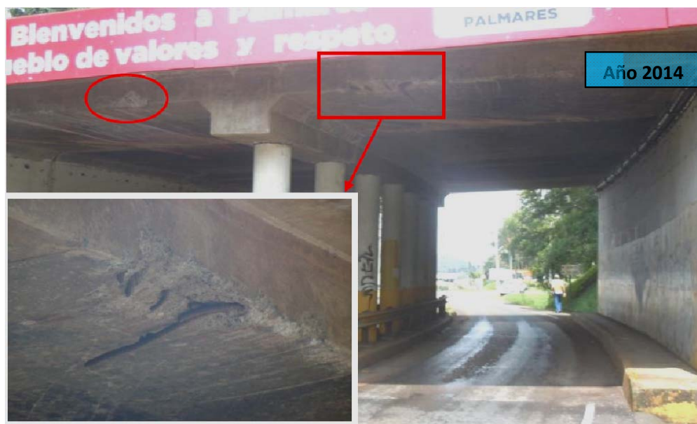
F48: Paso a desnivel sobre la ruta 135. Evidencia de impacto vehicular sobre la estructura (informe LM-PI-UP-PC01-2014). La condición se mantiene.
