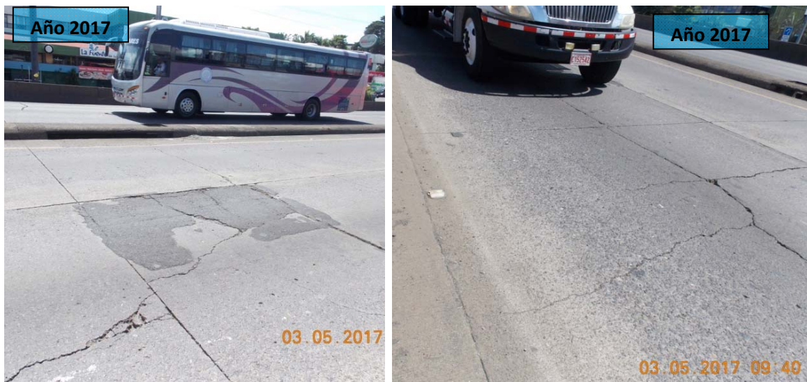
F8: Puente Juan Pablo II . Agrietamiento y bacheo en la losa de aproximación del puente en la superestructura con dirección Alajuela-San José, del sector de San José
