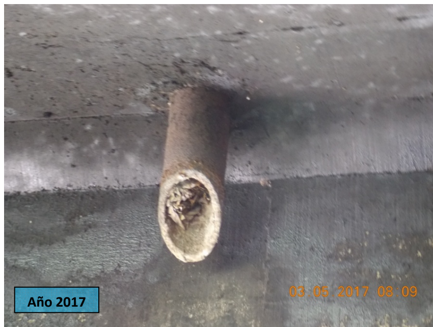
F4: Puente sobre el río Torres. Drenajes obstruidos con tapones y sobrecapa de asfalto
