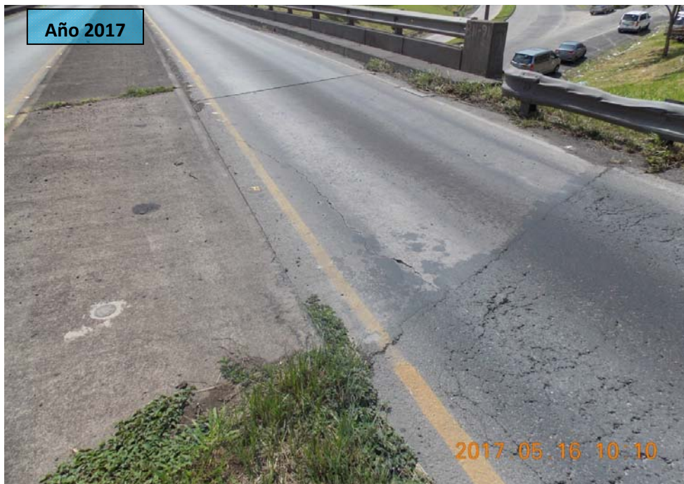
F22: Paso Superior Aeropuerto (Radial F.O). Deterioro en la losa de aproximación, el pavimento del acceso y la junta en el sentido San Ramón - Alajuela
