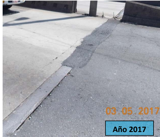
F9: Puente Juan Pablo II. Junta de expansión en la superestructura con dirección San José - Alajuela cubierta con una sobrecapa de 15 cm de espesor, del sector de Alajuela. Placa de acero en lugar de la junta dentada original de diseño en superestructura con sentido Alajuela - San José. Se observa una grieta paralela a la junta en la losa del tablero en la reparación reciente; la grieta presenta inclusive pequeños desprendimientos
