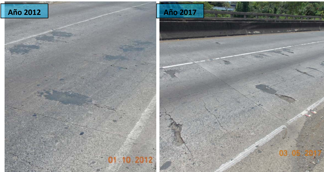
F16: Puente sobre el río Segundo. Incremento en la severidad del daño por agrietamiento y desprendimiento en la losa de concreto. Superestructura en dirección Alajuela - San José
