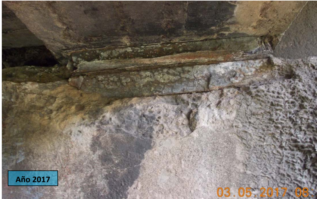
F7: Puente sobre el río Torres . Condición de deterioro en el apoyo (Bastión noroeste)
