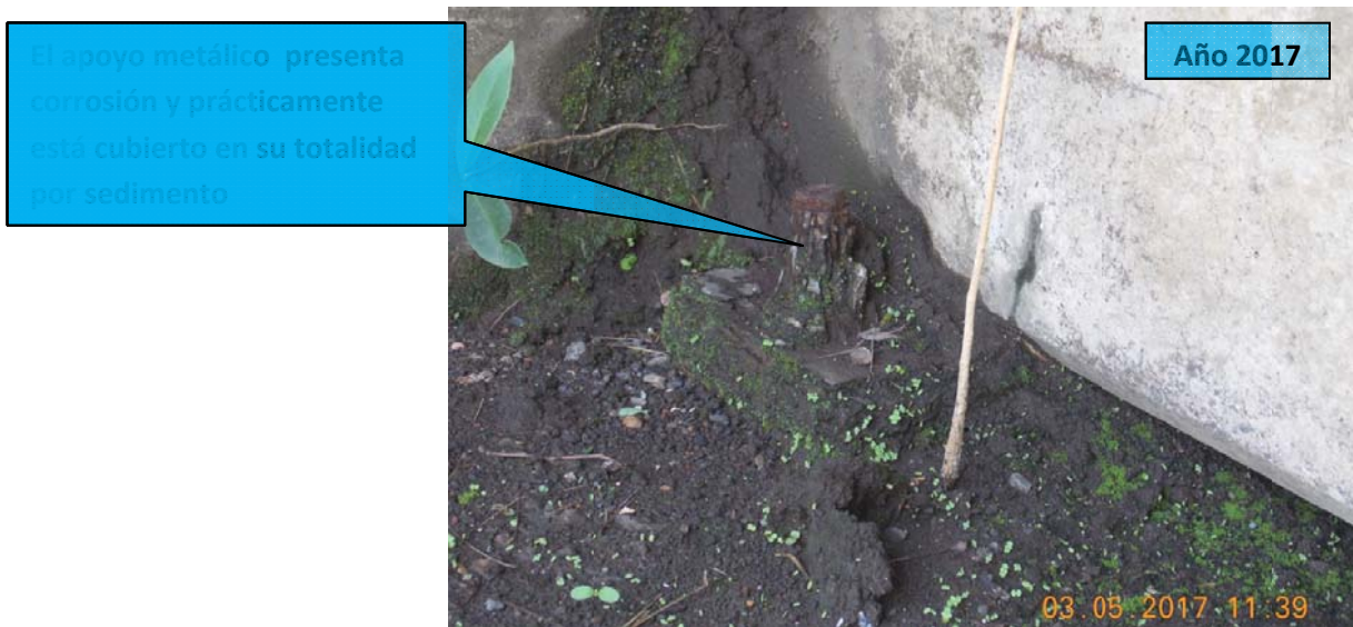
F18: Puente sobre el río Segundo. Estado del apoyo de las vigas sobre el bastión en el acceso del lado de Alajuela, superestructura en el sentido Alajuela-San José
