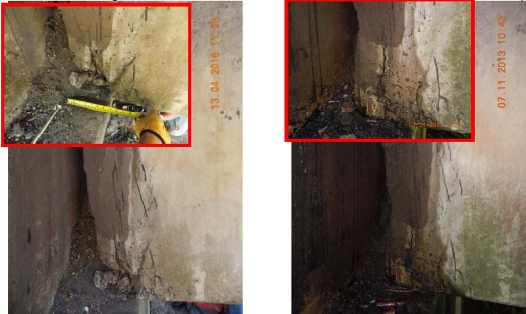
F38: Puente Rafael Iglesias (sobre el río Colorado). Progresión del daño en el apoyo de la viga externa aguas abajo sobre el bastión de acceso hacia San Ramón (ver nota informe LM-UP-15-2016).
