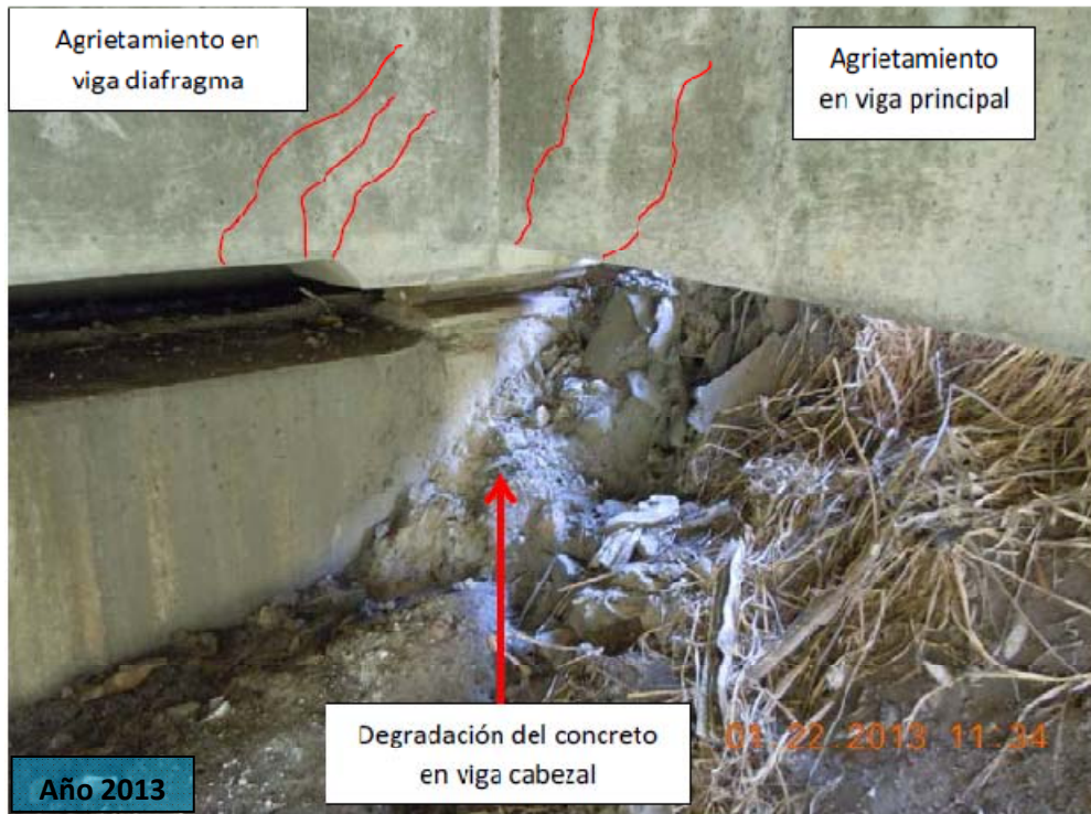
F32: Puente sobre el río Poás. Agrietamiento en viga diafragma y viga principal en la zona vecina al apoyo sur en el bastión este (informe LM-PI-UP-PC04-2013). La condición descrita se mantiene.
