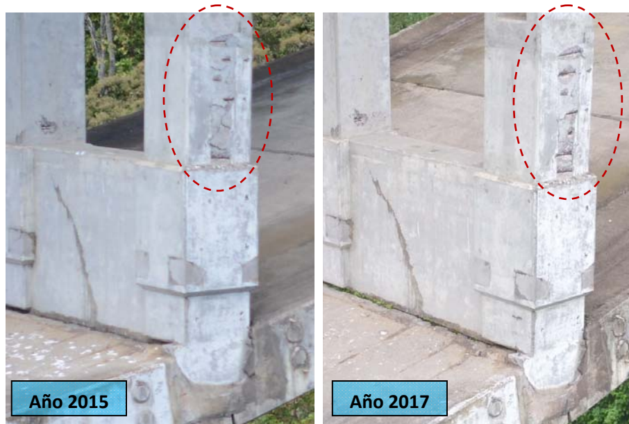
F40: Puente Rafael Iglesias (sobre el río Colorado). Progresión del deterioro por desprendimiento de concreto. Imágenes capturadas mediante uso de un drone, izquierda febrero del 2015 y derecha junio del 2017. No se observó cambio significativos en las otras afectaciones, como la grieta diagonal, que se observan en la figura
