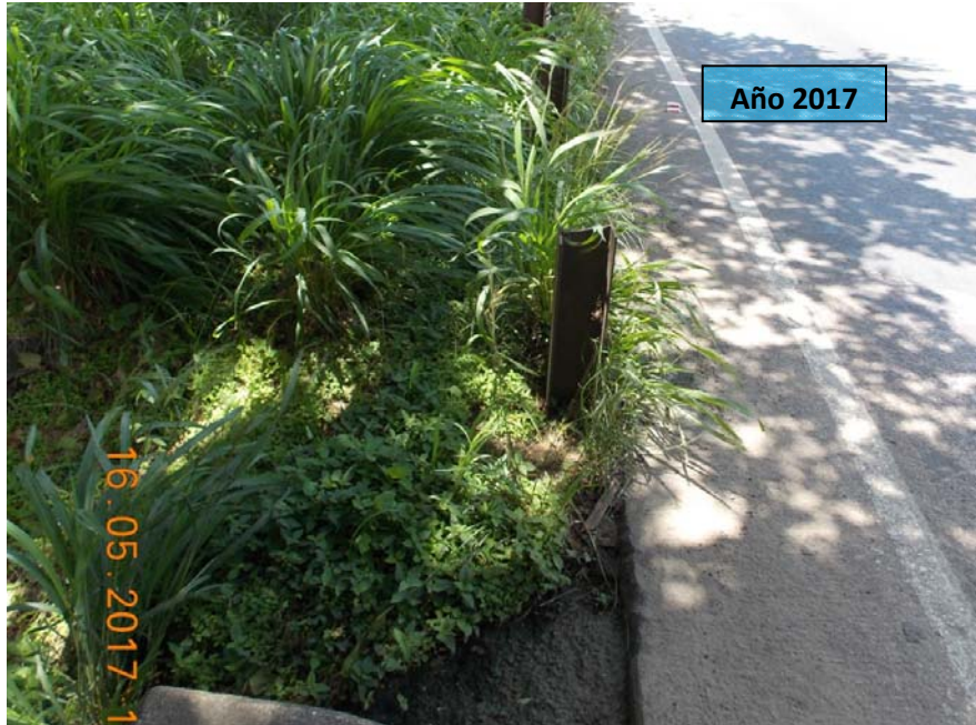
F27: Puente sobre el río Alajuela. Faltante del guardavía
