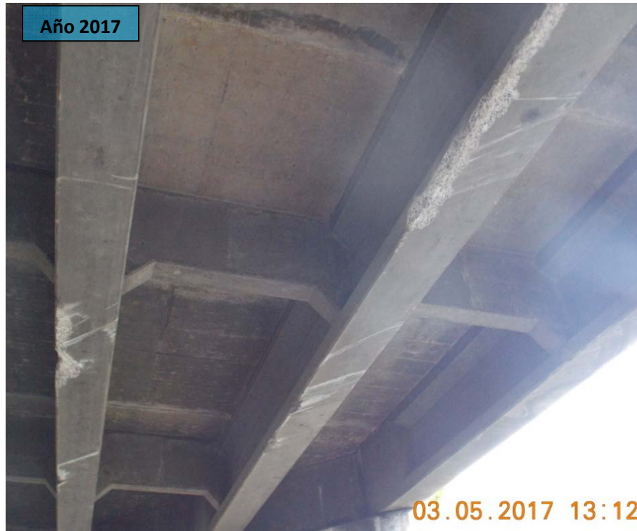
F19: Paso Superior Aeropuerto (Entrada Terminal). Impacto vehicular en las vigas principales de la superestructura en la dirección San José - Terminal JSM
