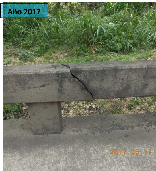
F42: Puente sobre el río Grande (km 47+640). Daños por impacto vehicular en la barrera de contención del puente
