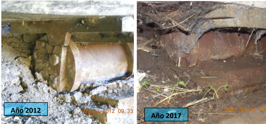
F37: Puente sobre el río Rosales. Progresión del deterioro en los apoyos del puente en el bastión este entre marzo del 2012 y mayo del 2017. Se evidencia la falta de mantenimiento sobre estos elementos del puente durante este periodo
