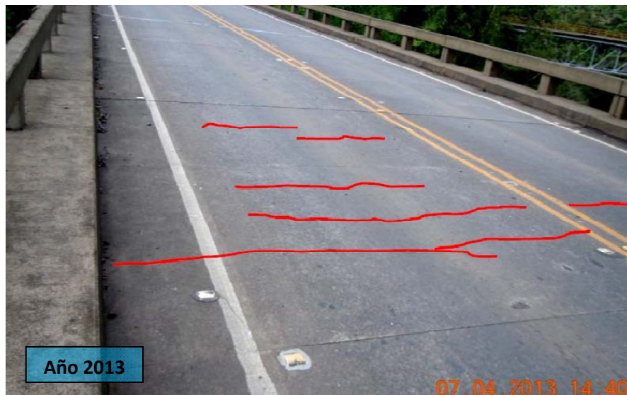
F44: Puente sobre el río Grande (km 47+640). Agrietamiento predominante perpendicular a la dirección del tránsito en el tablero (informe LM-PI-UP-PC02-2014). La condición se mantiene y también se observó agrietamiento en dos direcciones y eflorescencia en la cara inferior de la losa
