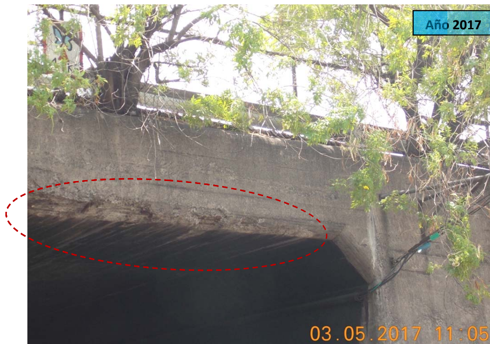
F14: Paso Superior sobre Ruta 129. Fotografías evidenciando crecimiento de vegetación sobre la losa del puente y la presencia de impacto vehicular
