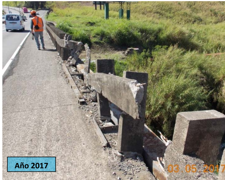
F3: Puente sobre el río Torres. Faltantes por impacto en la barrera vehicular en el sentido Alajuela-San José
