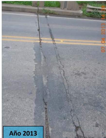
F43: Puente sobre el río Grande (km 47+640). Incremento del deterioro en la junta de expansión y señalización horizontal entre julio del 2013 y mayo del 2017 (acceso en dirección a Alajuela)
