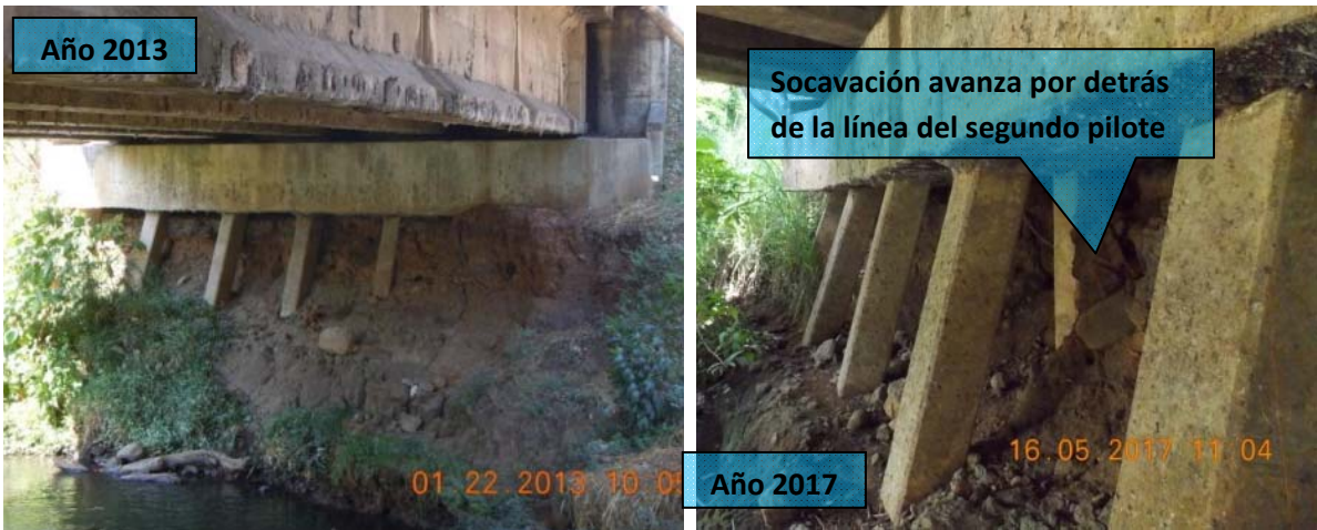
F28: Puente sobre el río Alajuela. La figura muestra el cambio entre enero del 2013 y mayo del 2017 en la socavación del bastión en el acceso en dirección a San Ramón. Actualmente la socavación llega hasta el segundo pilote (penetración desde la cara del bastión de 1,7 m).
