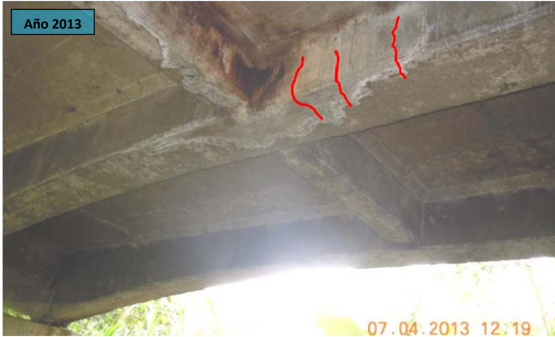
F53: Puente sobre el río Grande (km 54+370). Agrietamiento y deterioro por humedad en las vigas de la estructura de concreto. La condición se mantiene.
