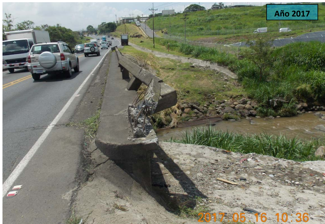
F24: Puente sobre el río Ciruelas. Barrera presenta impacto vehicular reciente en el sentido San Ramón - Alajuela. No existe guardavías en este sector
