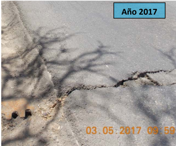
F9: Puente Juan Pablo II. Junta de expansión en la superestructura con dirección San José - Alajuela cubierta con una sobrecapa de 15 cm de espesor, del sector de Alajuela. Placa de acero en lugar de la junta dentada original de diseño en superestructura con sentido Alajuela - San José. Se observa una grieta paralela a la junta en la losa del tablero en la reparación reciente; la grieta presenta inclusive pequeños desprendimientos
