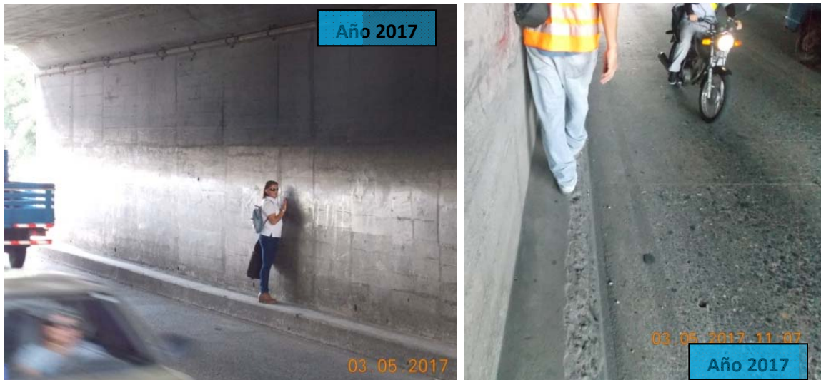
F13: Paso Superior sobre Ruta 129. Fotografías evidenciando condición peligrosa de los peatones al utilizar la ruta 129 para cruzar la Ruta No. 1
