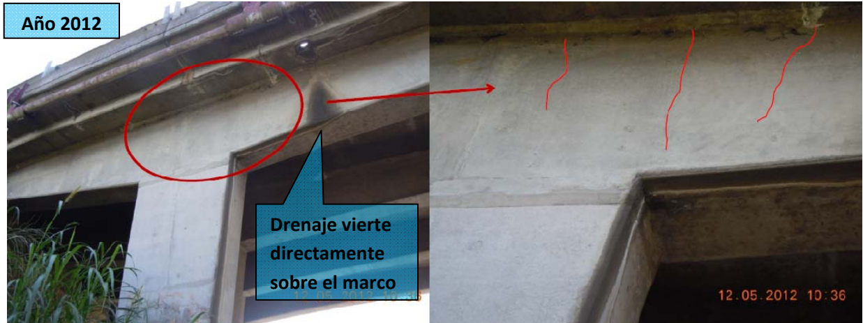
F21: Paso Superior Aeropuerto (Radial F.O). Agrietamiento por flexión en vigas principales del marco. Se puede observar también como el drenaje vierte el agua directamente sobre las vigas de concreto reforzado. Imagen del Informe de inspección. La condición se mantiene.
