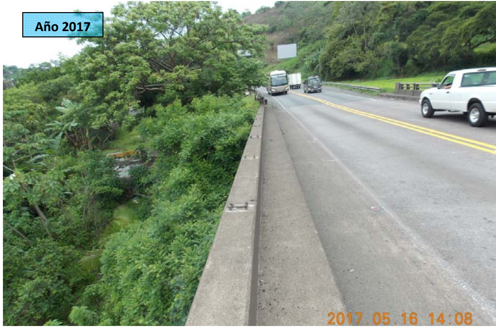
F35: Puente sobre el río Rosales. Faltantes en barrera de contención vehicular sobre el puente
