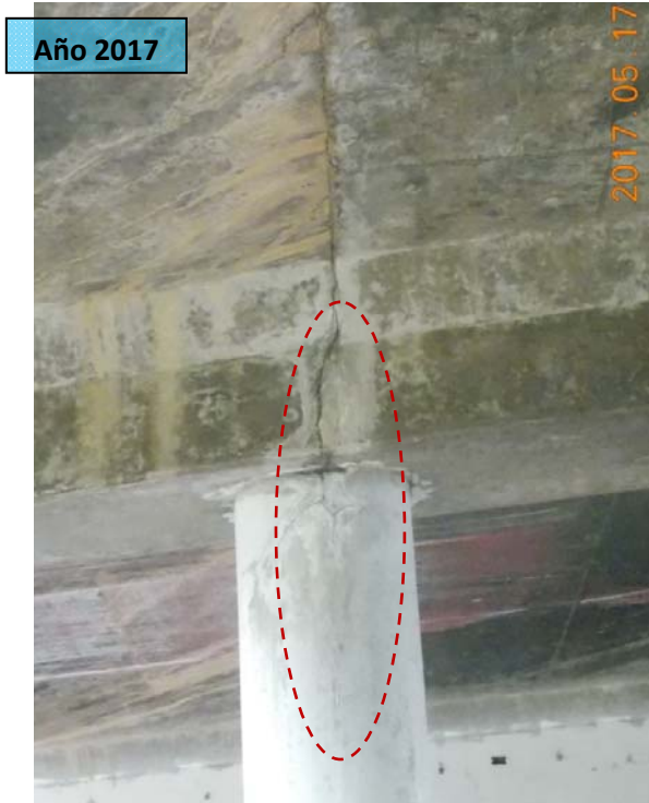
F51: Paso a desnivel sobre la ruta 135. Agrietamiento en la unión entre las columnas que conforman del pilas y la losa del tablero
