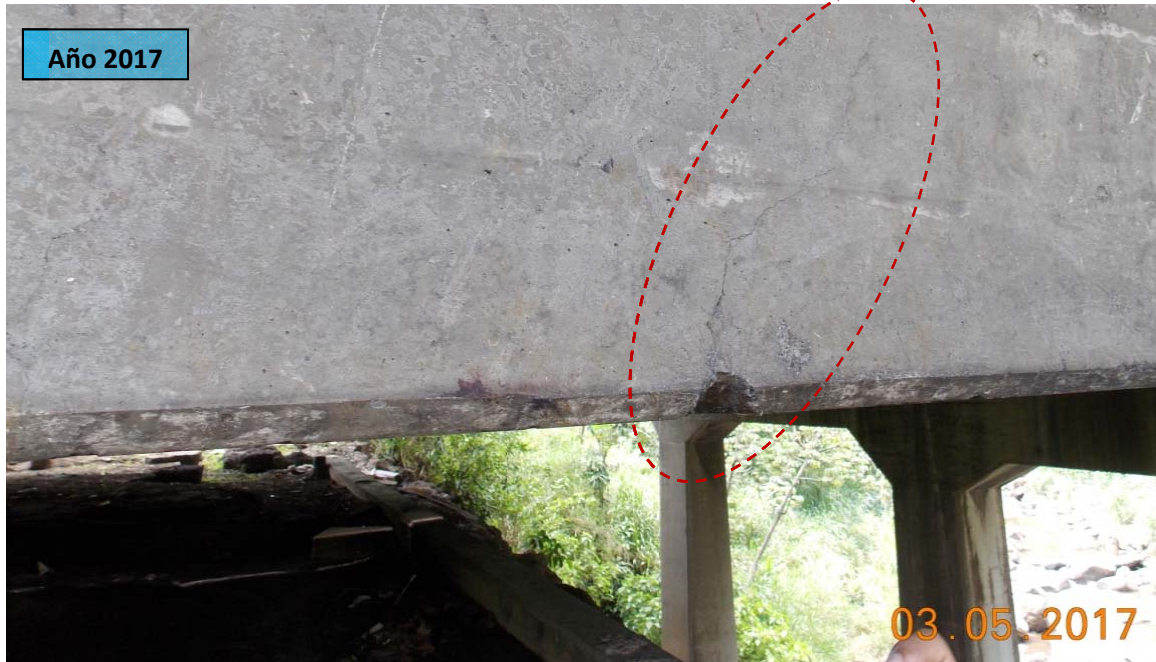
F17: Puente sobre el río Segundo. Agrietamiento por cortante y desprendimiento en la viga principal de concreto
