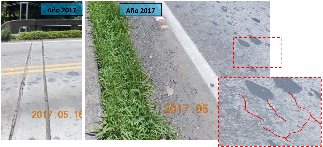
F29: Puente sobre el río Alajuela. Sello en juntas de expansión deteriorados y tablero con vegetación y agrietamiento en 2 direcciones
