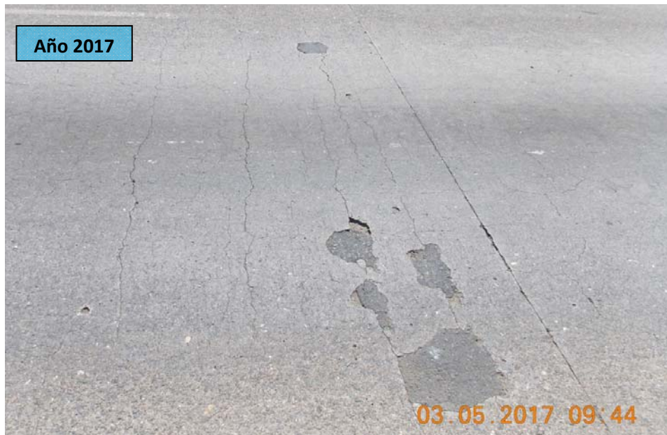
F10: Puente Juan Pablo II. Agrietamiento y desprendimiento de concreto en la cara superior de la losa de concreto en la superestructura con dirección vehicular Alajuela-San José
