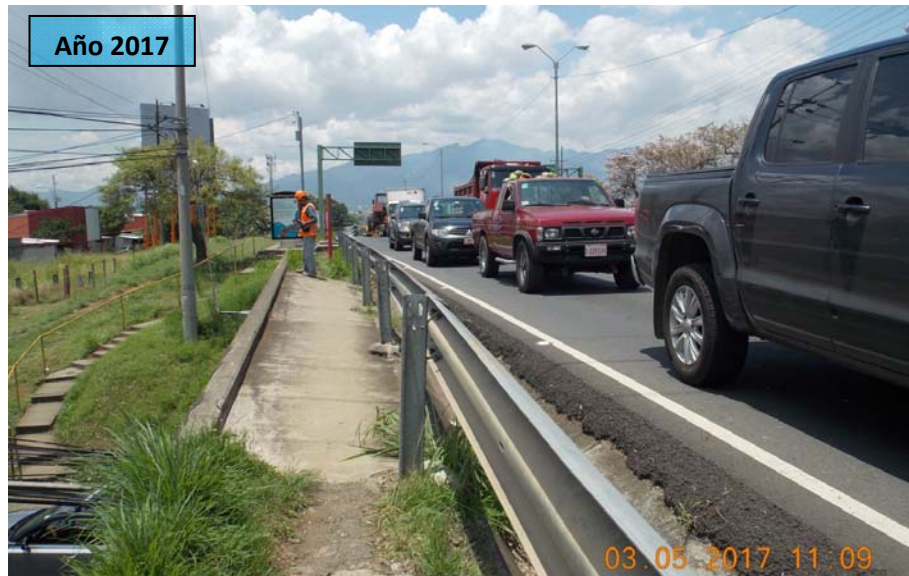
F12: Paso Superior sobre Ruta 129 . Colocación de barrera vehicular tipo flex-beam
