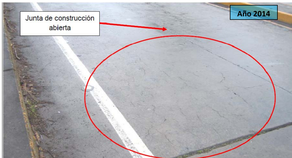
F50: Paso a desnivel sobre la ruta 135. Agrietamiento en dos direcciones (losa en calzada sureste, informe LM-PI-UP-PC01-2014). La condición se mantiene y además la losa presenta algunos desprendimientos cerca a las juntas de expansión
