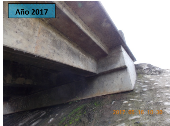
F26: Puente sobre el río Ciruelas. Nuevas obras de protección de los rellenos de aproximación y pantallas en los voladizos de la superestructura. La protección se realizó en ambos márgenes del cauce
