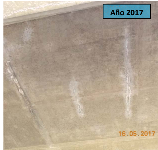
F23: Paso Superior Aeropuerto (Radial F.O). Agrietamiento en dos direcciones y eflorescencia en el tablero del puente
