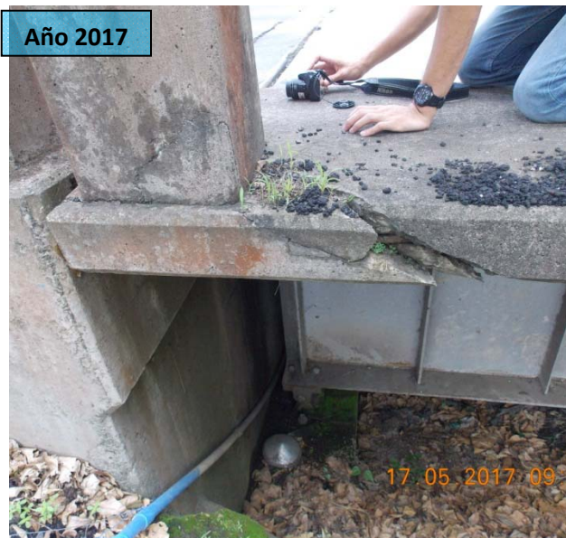
F42: Puente sobre el río Grande (km 47+640). Daños por impacto vehicular en la barrera de contención del puente
