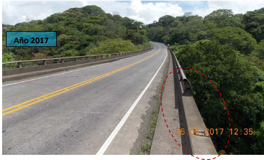
F31: Puente sobre el río Poás. Faltantes en barrera de contención vehicular sobre el puente
