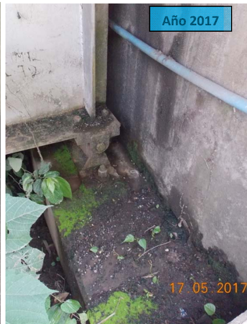
F47: Puente sobre el río Grande (km 47+640). Deterioro por corrosión en apoyos, además acumulación de escombros en el entorno del apoyo e insuficiente longitud de apoyo
