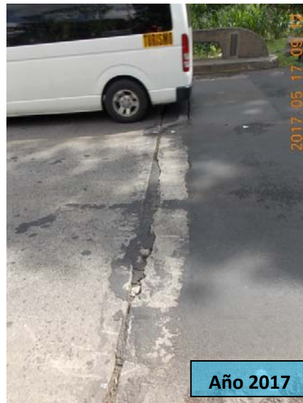
F43: Puente sobre el río Grande (km 47+640). Incremento del deterioro en la junta de expansión y señalización horizontal entre julio del 2013 y mayo del 2017 (acceso en dirección a Alajuela)
