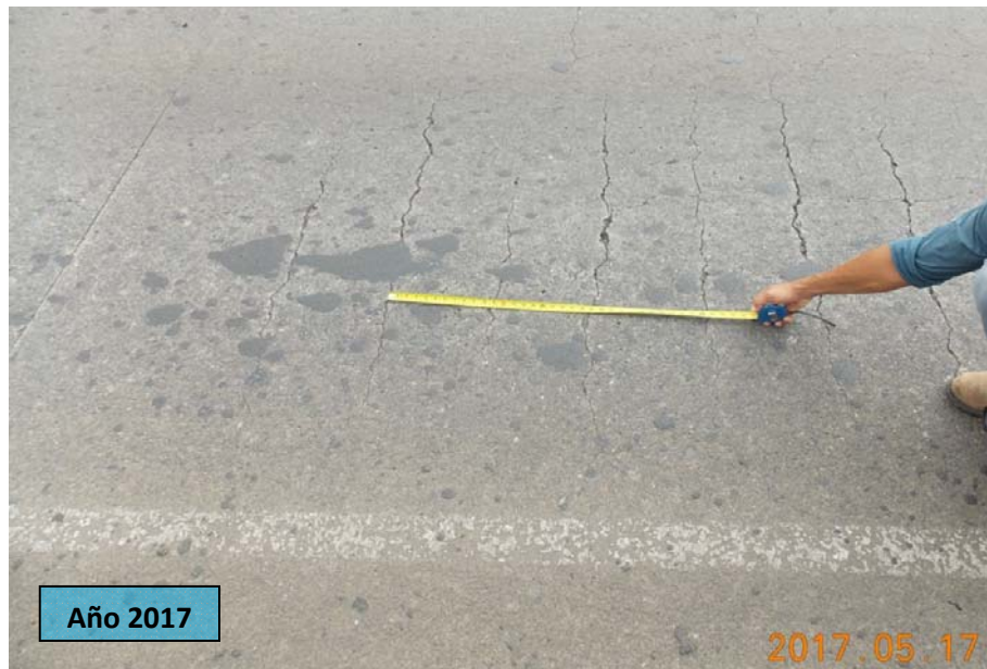
F54: Puente sobre el río Grande (km 54+370). Agrietamiento en una dirección generalizado en la losa del tablero
