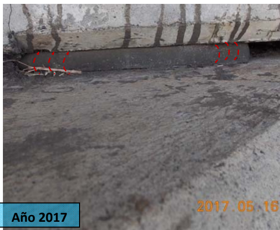
F20: Paso Superior Aeropuerto (Entrada Terminal). Apoyo cuya deformación evidencia sobrecarga o pobre desempeño de los apoyos utilizados
