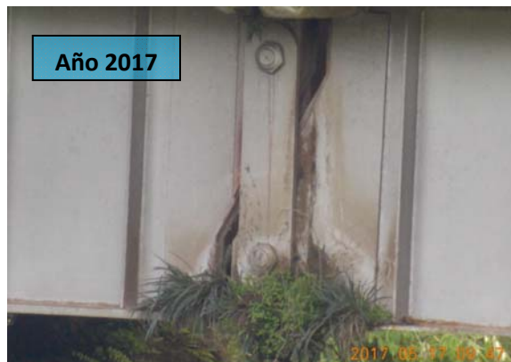
F46: Puente sobre el río Grande (km 47+640). Condición observada en el apoyo expansivo en la unión tipo Gerber. Es necesario inspeccionar con mayor detalle el elemento ya que este es un elemento considerado como con posibilidad de falla crítica por fatiga. No fue posible evaluar si el elemento presenta algún grado de corrosión
