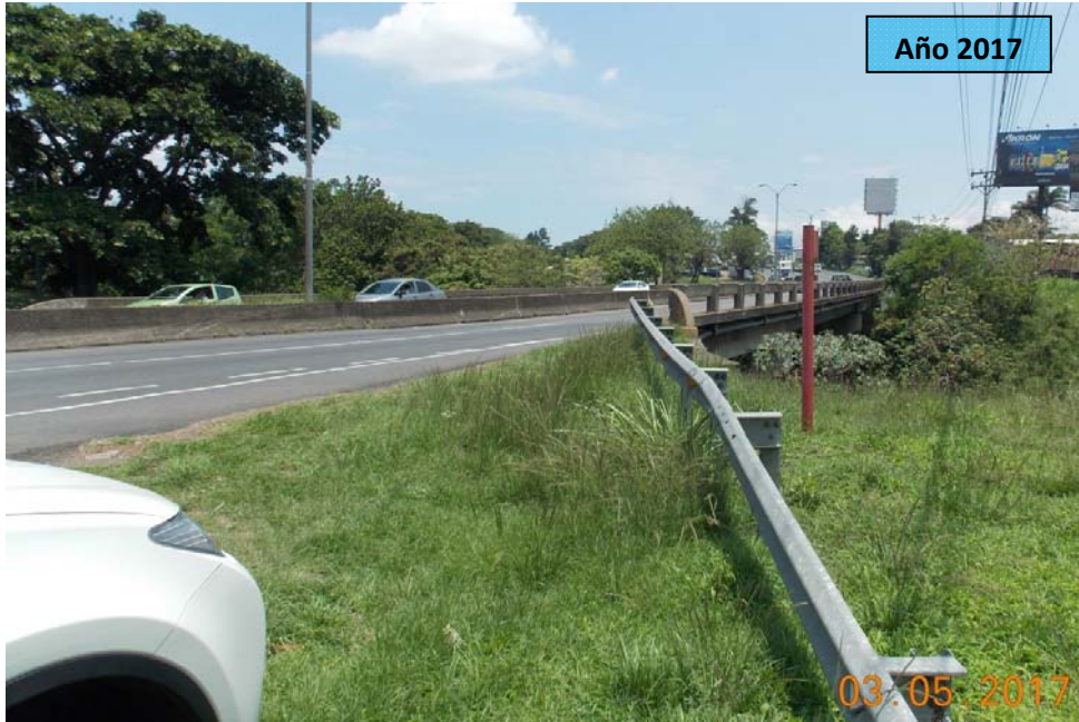
F15: Puente sobre el río Segundo. Colocación de guardavías vehicular tipo flex-beam
