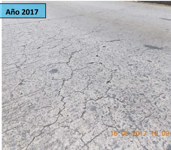
F23: Paso Superior Aeropuerto (Radial F.O). Agrietamiento en dos direcciones y eflorescencia en el tablero del puente
