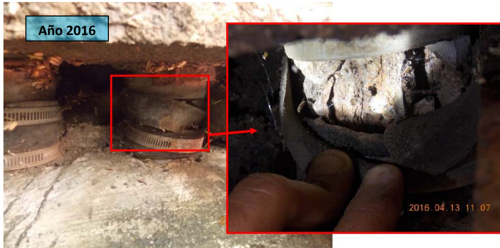
F39: Puente Rafael Iglesias (sobre el río Colorado). Cables de pos-tensión que pasan bajo las juntas de expansión presentan deterioro en el recubrimiento y corrosión severa (ver nota informe LM-UP-15-2016). La junta está actualmente obstruida con asfalto
